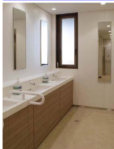
洗面コーナーは、水濡れを心配せずに靴や化粧ポーチなどを置くことができるように、ツインデッキカウンターを採用。
