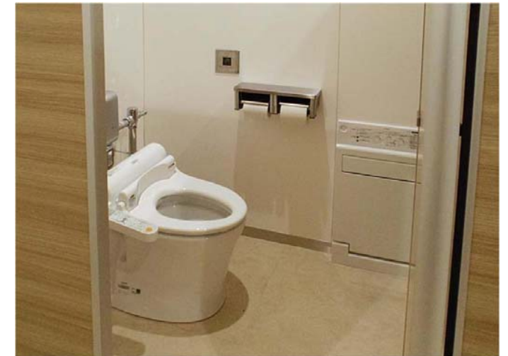
男性トイレの大便器ブースの1ヶ所にも、着替えができるフィッティングボードを設置している。
