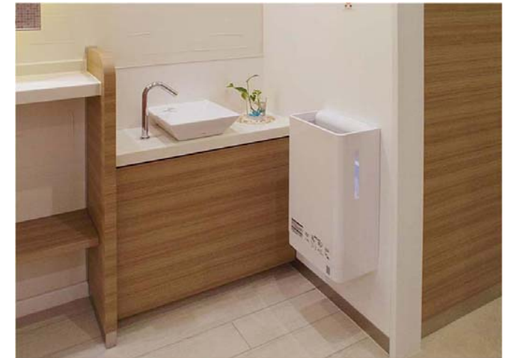
お化粧直しの後に手洗いができるように手洗器を設置。横には手洗い後の床への水垂れを抑えるため、クリーンドライを設置している。
