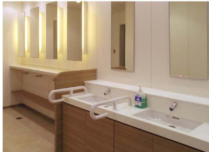
洗面器を3ヶ所に減らし、そのスペースを活用してパウダーコーナーを新設。洗面器の水栓金具は、水じまいがよく節水効果も図れる壁付きの自動水栓を設置している。
