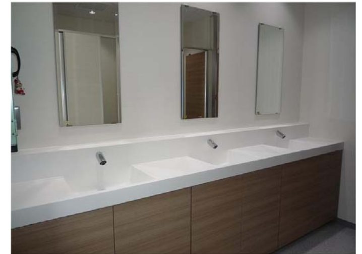
改修後はTOTOの洗面器一体型ツインデッキカウンターを採用。上部棚をドライエリアとして使えるため、ディスプレイにも適している。
