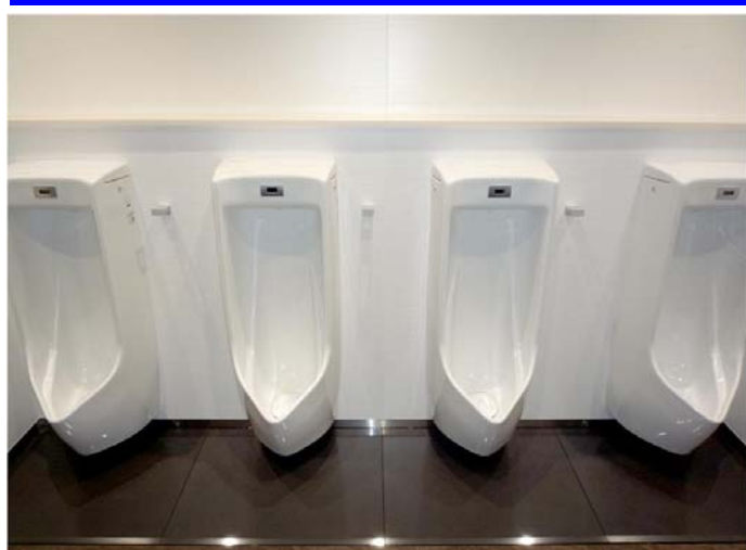
子供から大人まで幅広く使える、低リップタイプの小便器を設置。奥行きのあるライニングとフックで荷物置きスペースに配慮している。
