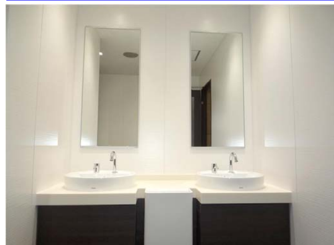
ベッセルタイプの丸型洗面器とカウンター埋め込み式のハンドドライヤーで使いやすさと床への水漏れの軽減に配慮。発電タイプの自動水栓により、停電時でも水が使えるようにしている。
